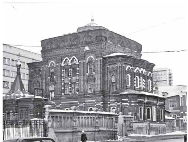
Церковь «Всех Скорбящих Радости» иконы Божией Матери (3-я Мещанская ул.) при больнице Московского областного научно-исследовательского клинического института
